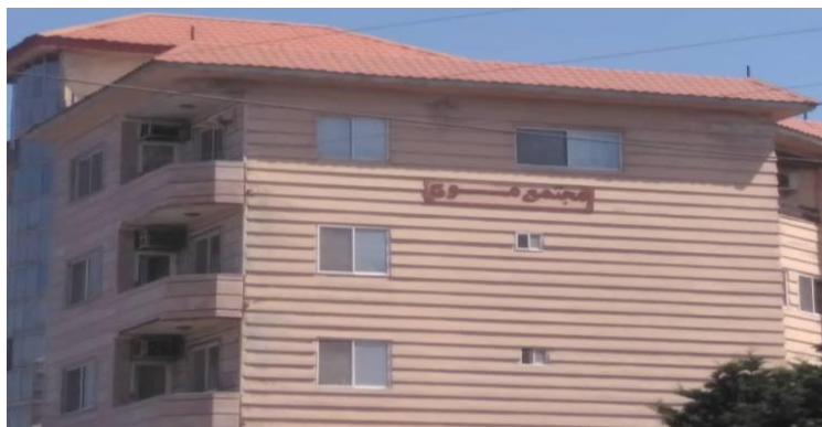
شکل ۱۵- جهت جنوبی سقف سفالی در محدوده پژوهش، ۹۸
