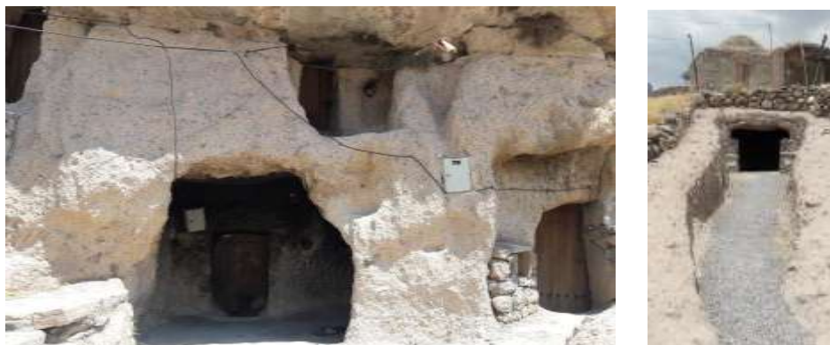
شکل ۷- سایه‌بان قابی شکل در بناهای خاک‌پناه میمند
